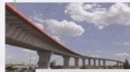
Pont de Cheviré (1986-1991) Pont routier de 1 563 m de long, il relie les rives de la Loire entre Cheviré et Roche-Maurice. Sa hauteur de 52 m permet le passage des navires. Son tablier central, 162 m, a été réalisé d'une seule pièce.
