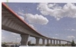
Pont de Cheviré (1986-1991) Pont routier de 1 563 m de long, il relie les rives de la Loire entre Cheviré et Roche-Maurice. Sa hauteur de 52 m permet le passage des navires. Son tablier central, 162 m, a été réalisé d'une seule pièce.
