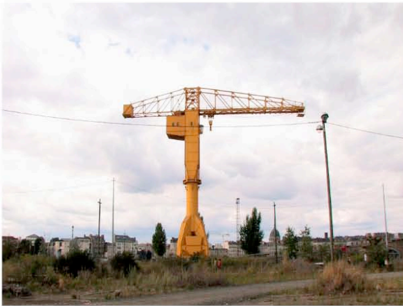
La grue Titan. Ancien emplacement des chantiers navals Dubigeon. Aujourd'hui.
