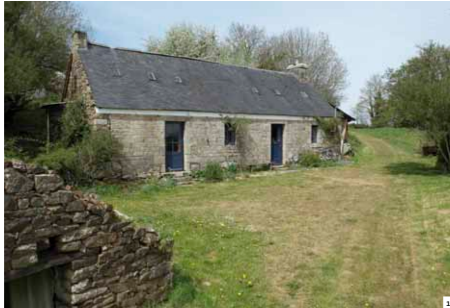
1 : Habitat mixte, 1896 (Scrignac). 2 : Habitat mixte, 2 e moitié 17 e siècle (Scrignac). 3 : Habitat mixte, 1860 (Berrien). 4 : Le site du Goenidou (Berrien). 5 : Ancienne ferme, milieu 19 e siècle (Huelgoat). 6 : Ancienne ferme, 1800 (Berrien). 7 : Élévation nord d'un logis (18 e -19 e siècle) avec kuz gwele (Huelgoat). 8 : Logis à avancée du 18 e siècle, transformé au 19 e siècle (Scrignac).
