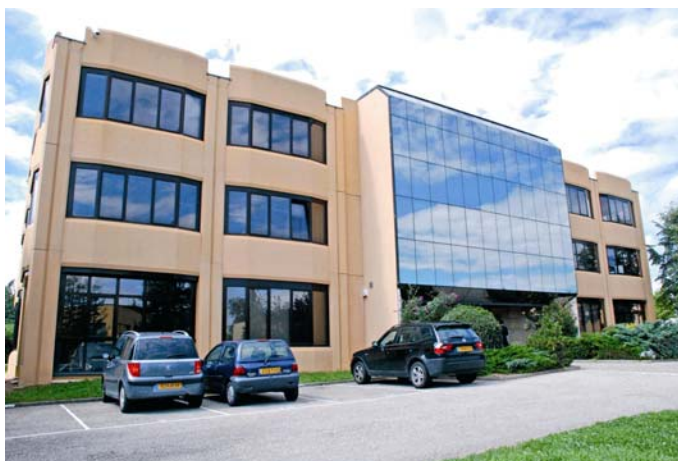
Siège social d'Illico Travaux à St Didier au Mont d'Or
