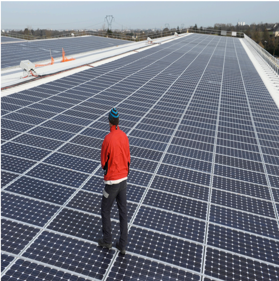
Pose des panneaux, le jeudi 21 janvier à Ploufragan
