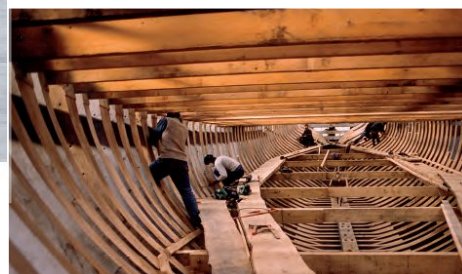
Etape de la construction.
